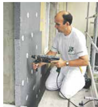
Die Fassadendämmung ist eine der wichtigsten Maßnahmen, um im Altbau die Energiekosten zu senken und gleichzeitig etwas für Umwelt- und Klimaschutz zu tun. Foto: djd/Fachverband Wärmedämm-Verbindungssysteme e.V.
