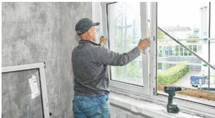
Alte Kunststofffenster werden ausgebaut und durch Modelle mit Recycling-Anteilen ersetzt. Foto: djd/REHAU AG + Co
