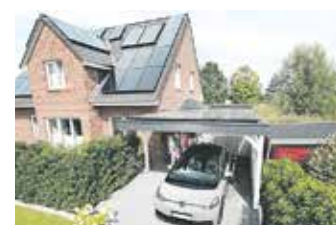
Mit einer Photovoltaikanlage und einer Wallbox kann das E-Auto Sonnenstrom vom eigenen Dach „tanken“. Foto: djd/E.ON/Malte Braun
